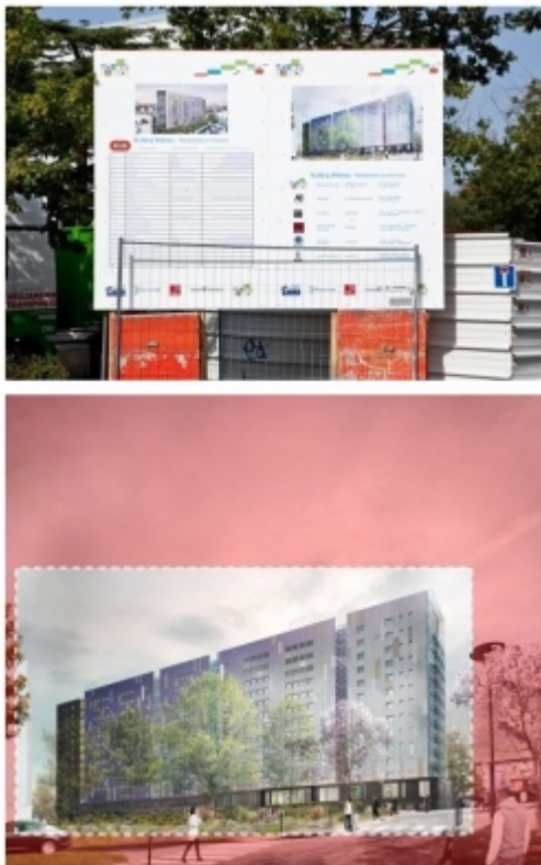
Vue du site du chantier, 2014 © Alban LÉCUYER.
